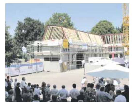
Richtfest des neuen Gebäudes auf Burg Wissem in Troisdorf.
