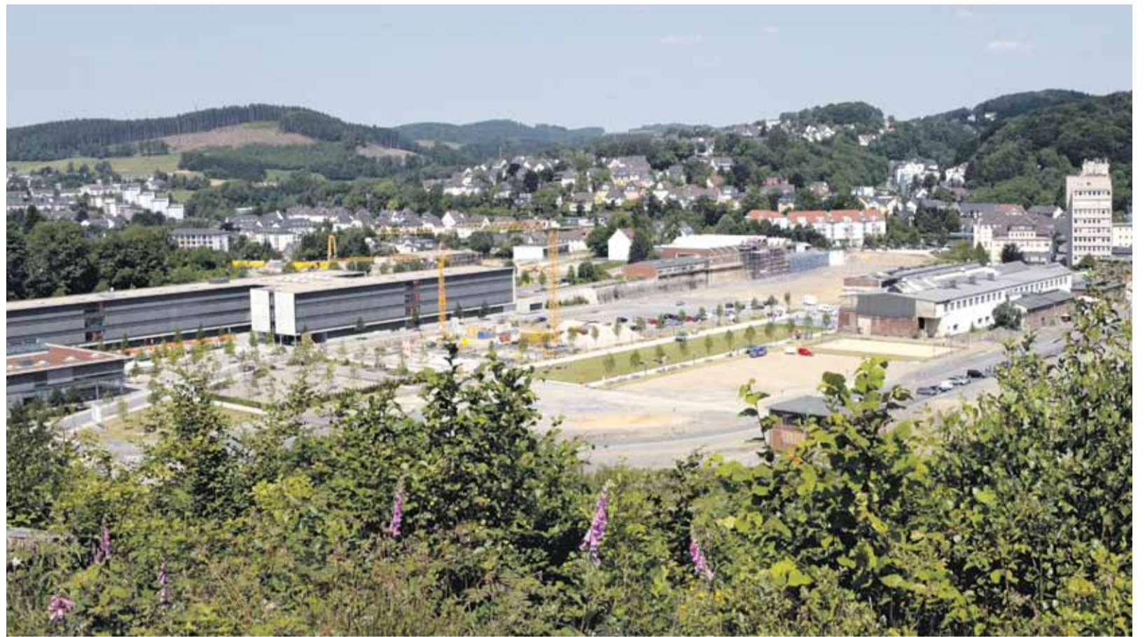
Auf dem Gelände des ehemaligen Kessel- und Anlagenbauers Steinmüller in Gammersbach erwächst ein neues und attraktives Stadtquartier.
