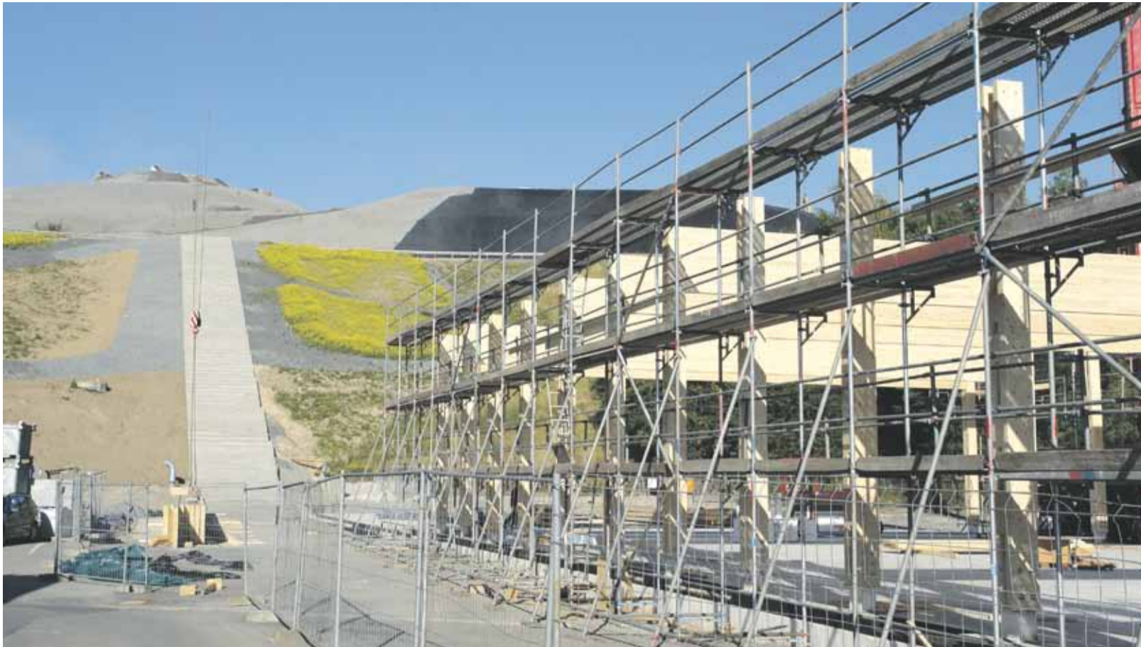
Aufbruch auf der Leppe: Das Transferzentrum :metabolon im Bau [fsw Landschaftsarchitekten + pier 7 Architekten, Düsseldorf].
