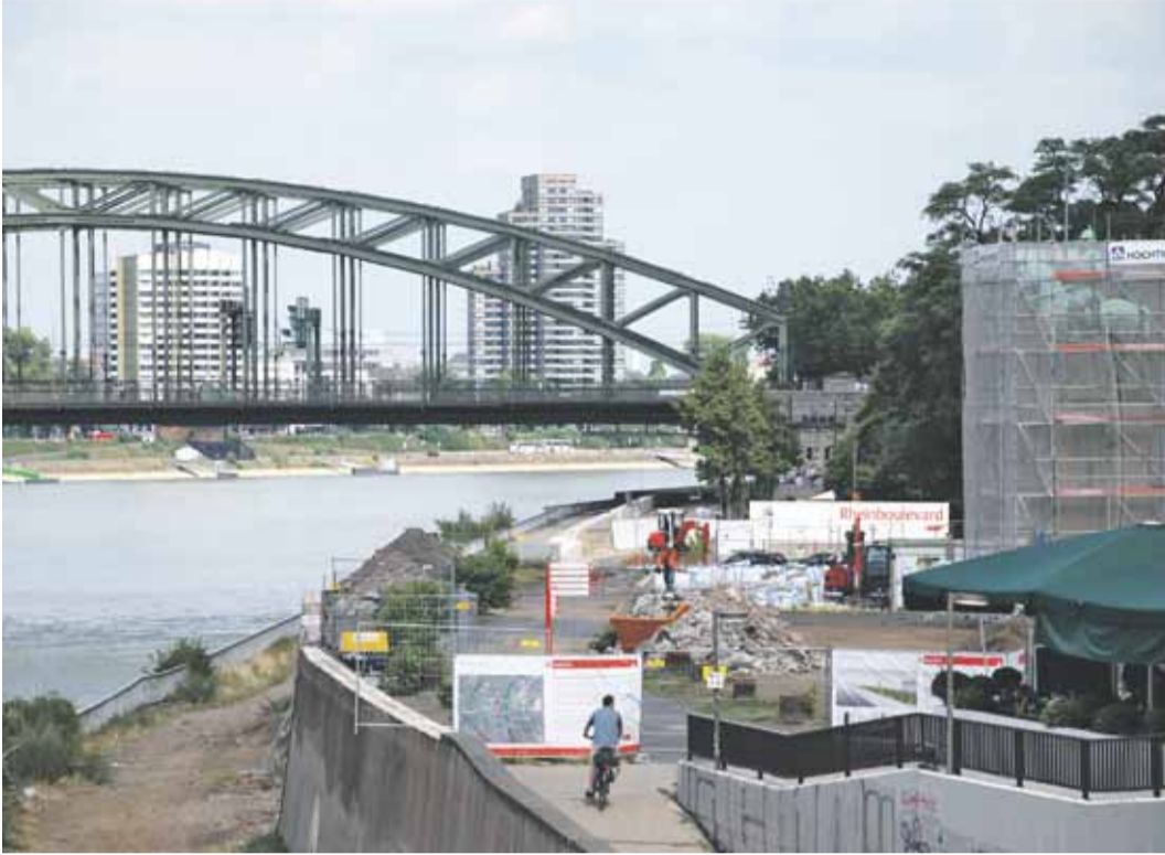
Baustelle des Rheinboulevards am Rheinufer in Köln Deutz [Stand Sommer 2010]...
